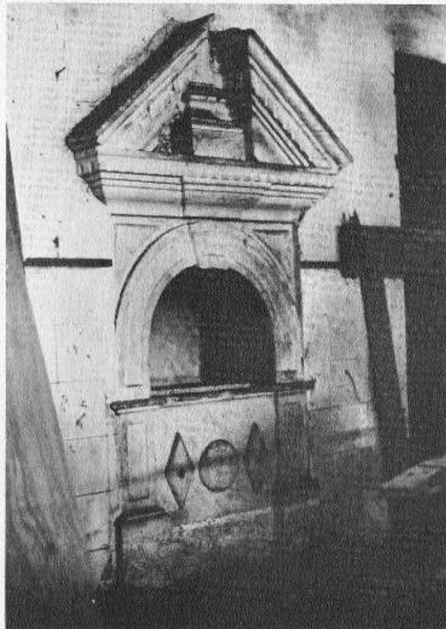
9 – Quinta do Tanque – Pia existente no antigo refeitório.
