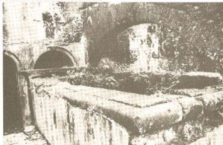
10 – “Banheiro dos Jesuítas” – Detalhe da cisterna.
