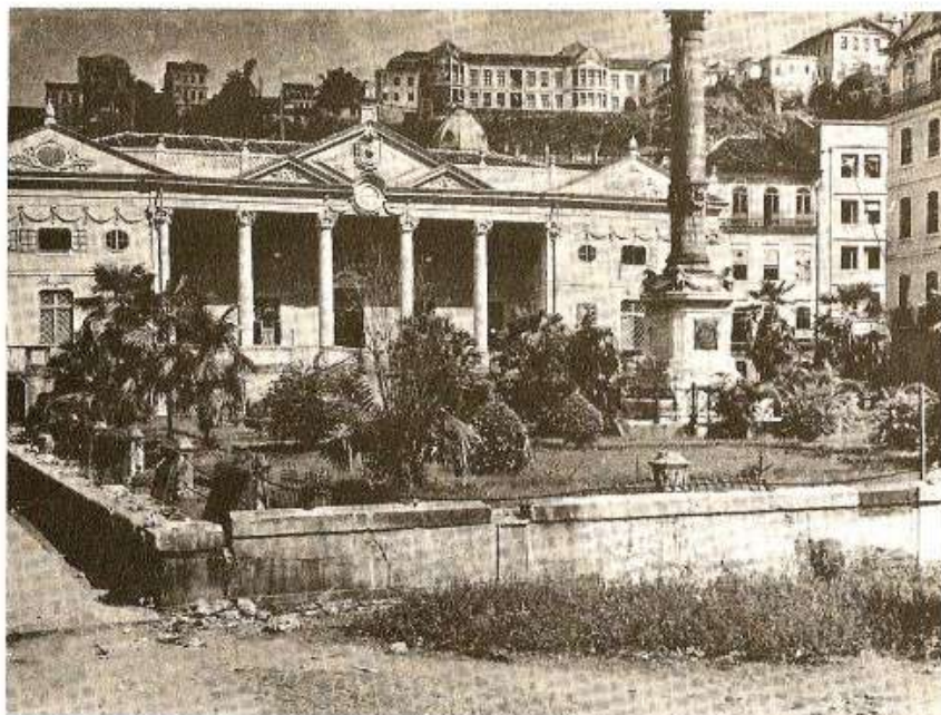
3 – Praça Riachuelo por ocasião das obras de prolongamento da Rua Miguel Calmon
