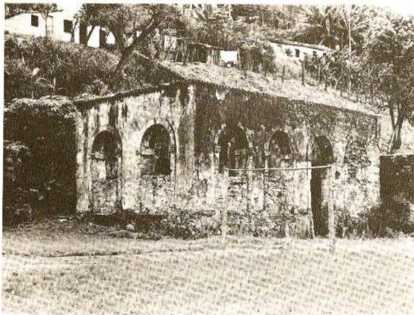
5 – “Banheiro dos Jesuítas” – Vista externa.
