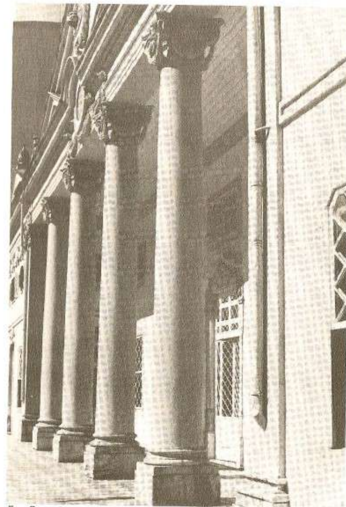
5 – Paço da Associação Comercial – Detalhe do Pórtico posterior.
