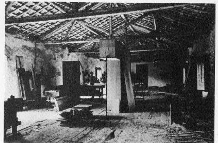
7 – Quinta do Tanque – Interior. Utilização atual.
