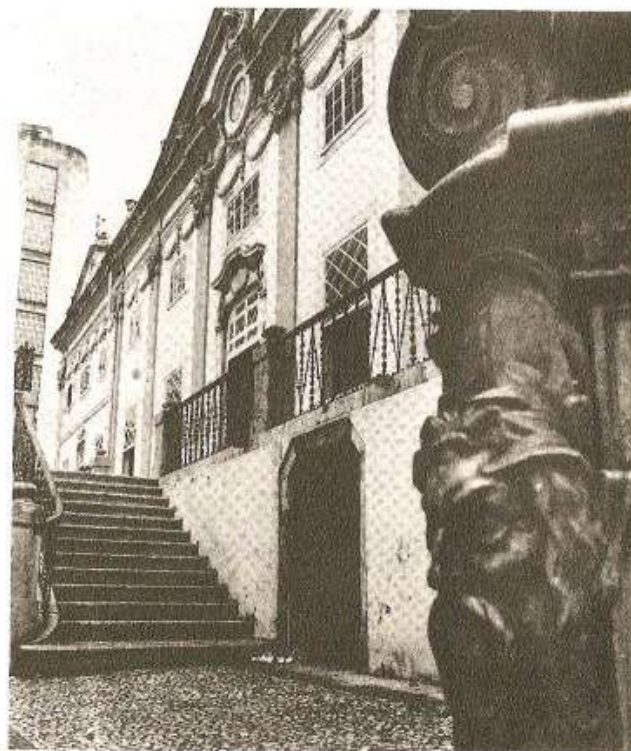
8 — Paço da Associação Comercial — Detalhe da fachada principal.
